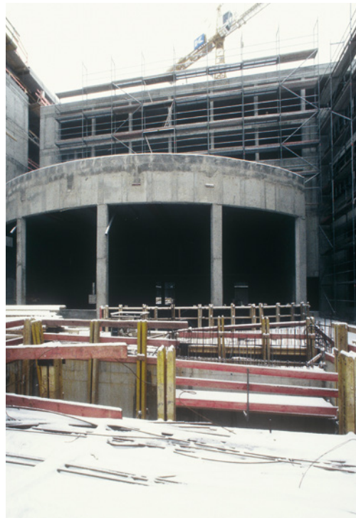
Rohbau und Fertigstellung, 1996
