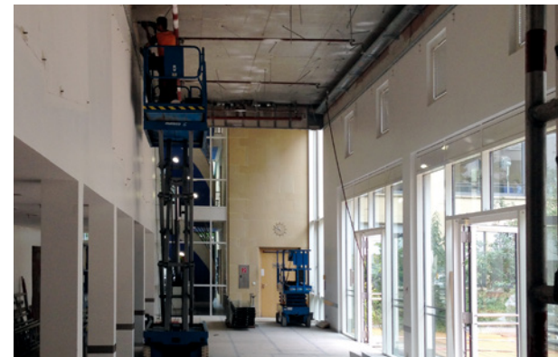
Umfangreiche Umbauten und Modernisierungsmaßnahmen im hbw, 2015
